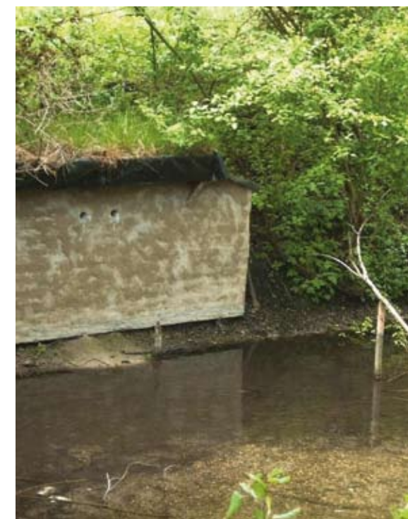
Fertige Brutwand mit zwei Röhren
